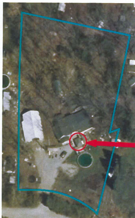
Image prise sur Gonet et annotée par l'inspectrice, montrant le balcon avant existant où sera installé le gazébo
