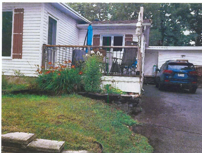
Photo prise par le propriétaire montrant le balcon avant existant où seront installés le spa et l'abri-soleil
